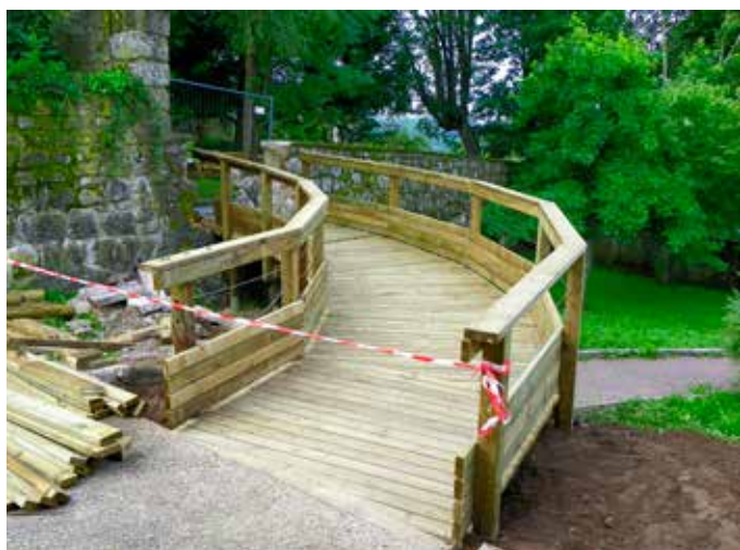
La passerelle RONDINO
