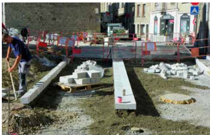
Pose pavés, caniveaux, bancs (taillés et livrés par entreprise MOULIN), construction murets, pose béton désactivé ; étanchéification bases des immeubles (entreprise ODTP de Polignac)
