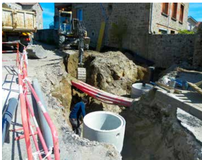
Tranchée mise en séparatif des eaux
