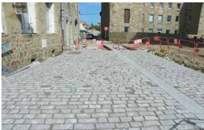
Vue du pavage (entreprise ODTP)
