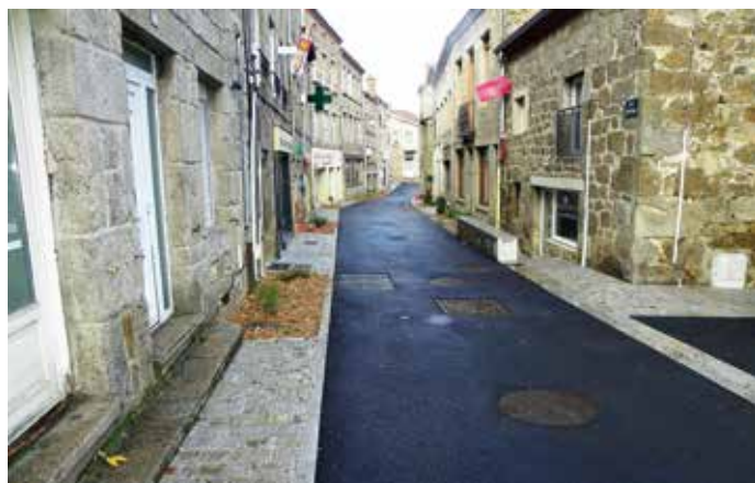
Installation terre végétale, plantations (entreprise MM Aménagements de Marlhes)
