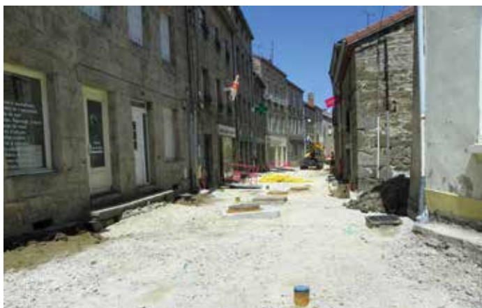
Déblaiement avant pose (entreprise CHANAVAT MOULIN des Villettes)
