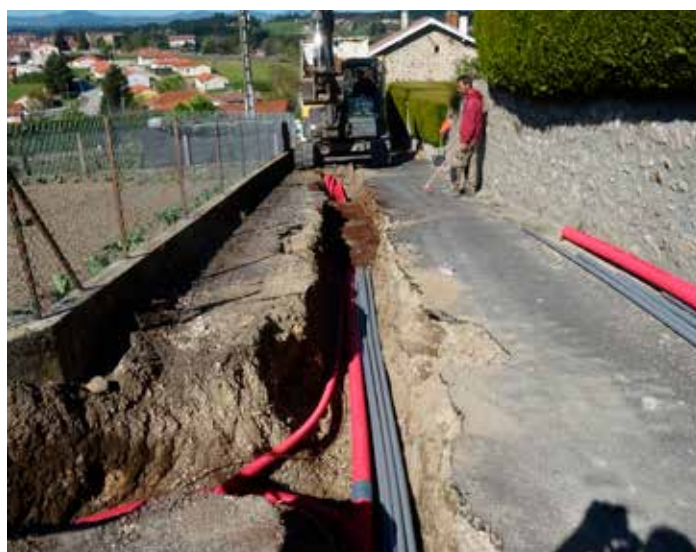
Travaux à la Pouyat
