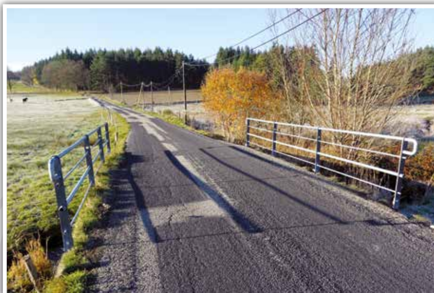
Barrière pont de Jourdy
