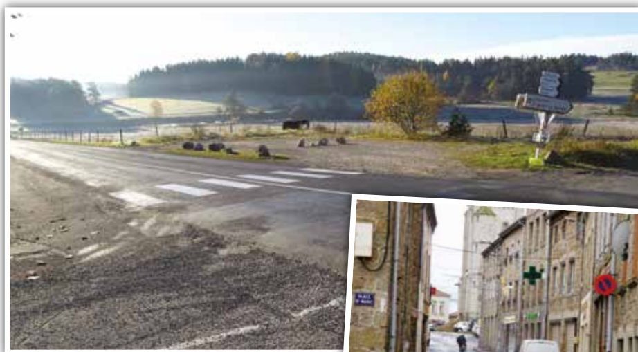
Sécurisation départementale Croix du détour
