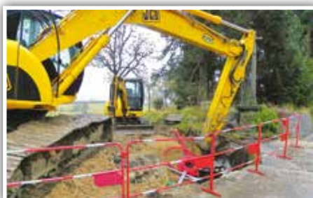
Creusement de la tranchée
