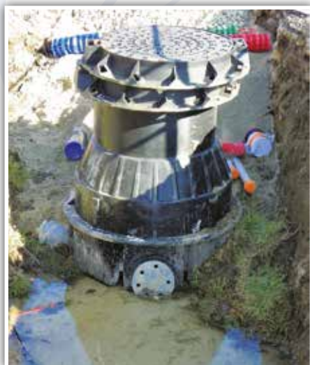
Tranchée et conduits
