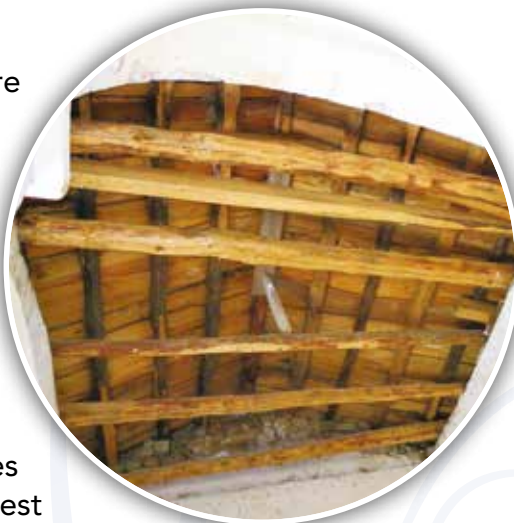
Toiture de la Chapelle
