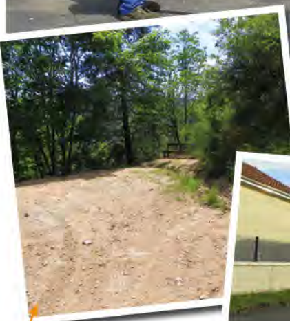
Réfection du chemin de Laval
