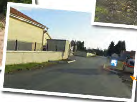
Nouvelle chaussée aux Amatis avec l'entreprise Charavat
