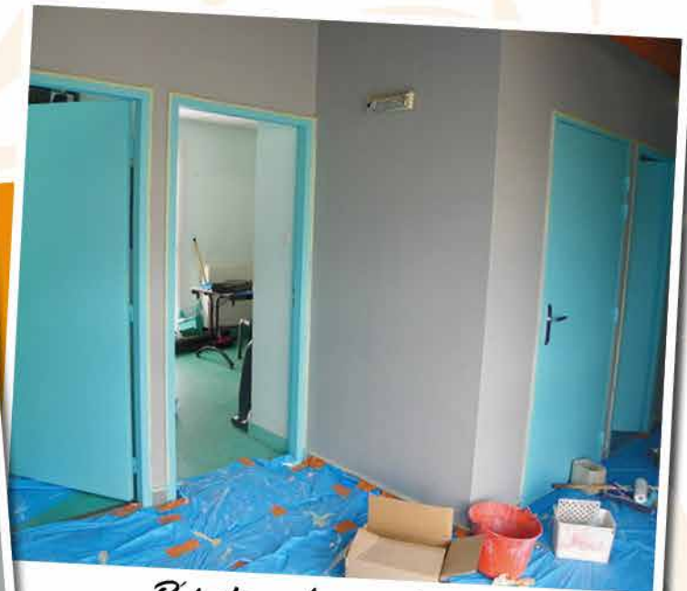
Refection des peintures de l'École Publique
